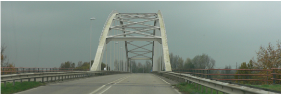
Hoge brug over Amsterdam-Rijnkanaal
