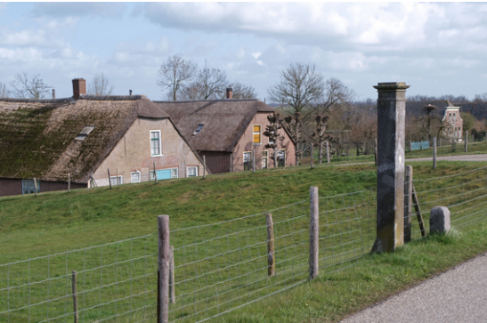
Boerderij onderaan de dijk
