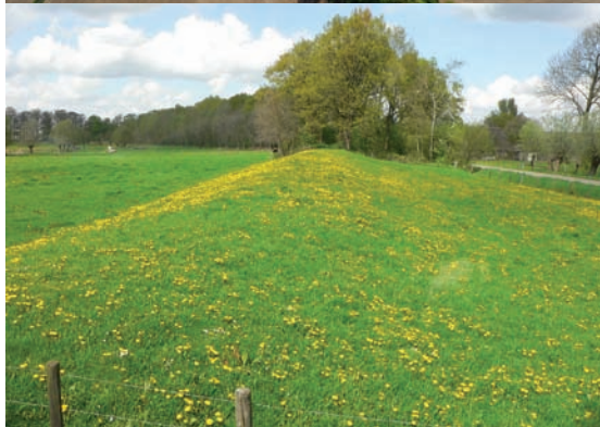
Boven; Slaperdijk bij Renswoude. Onder liniedijk
