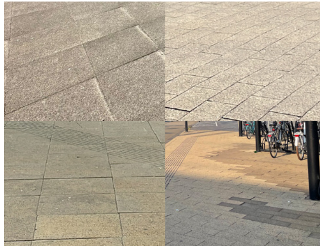
Bestaande tegels schoonspuiten Aanvullen met tegel in aansluitende kleur ( zand ) Struyk Verwo Betonstraatstenen
