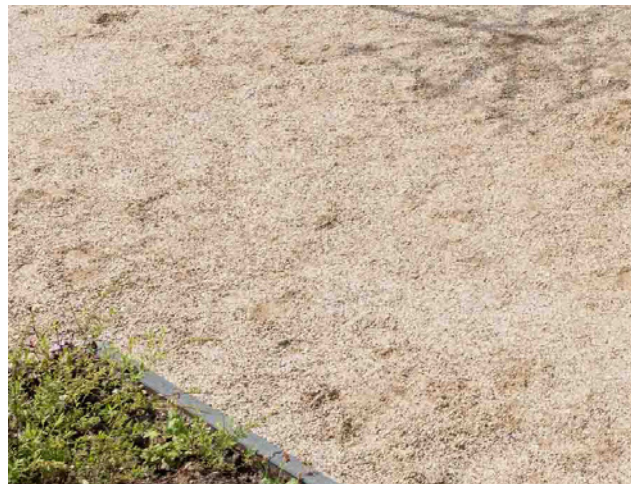
Halfverharding Achterhoeks padvast 0-6 mm Aan beide zijdes betonnen opsluitband van 10 cm breed
