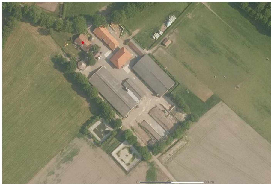
Luchtfoto van referentiesituatie
