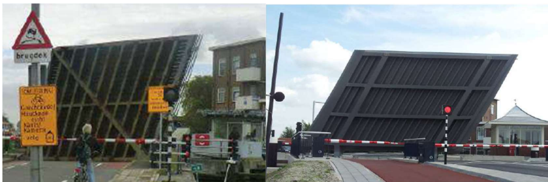
figuur 12 Beweegbare brug voor- en na vervanging van het val. Nieuwe val is groter, zwaarder én stiller. Ontworpen met 'geluidreductie' als opdracht. (foto's M+P)
