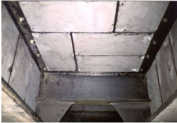
figuur 18 CLD op een stalen brug (foto uit: [4])
