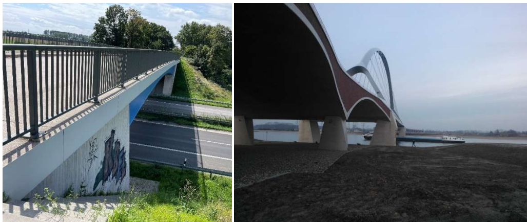
figuur 20 Hybride kunstwerken van staal en beton (foto's: M+P)
