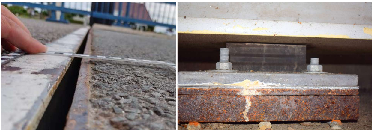
figuur 15 Hoogteverschil bij de voegovergang en speling in de oplegging door slechte afstelling en/ of temperatuurgedrag van het val leidt tot onnodige extra aanstoting en geluidtoename (foto's: M+P)
