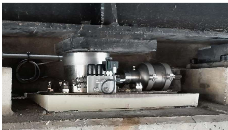
figuur 17 Zelfstellende oplegging (foto: M+P)
