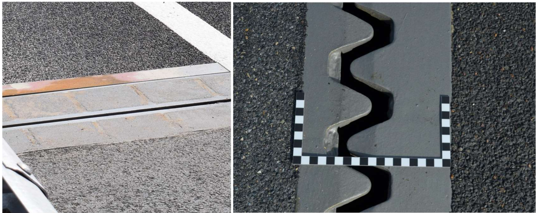
figuur 14 Links: voor geluid een ongunstige situatie met van boven naar beneden: de lawaaige slijtlaag en voegovergang en overgang naar akoestisch afwijkend asphalt. Rechts: val met stille voeg en stille slijtlaag op zowel de aanbrug als het val
