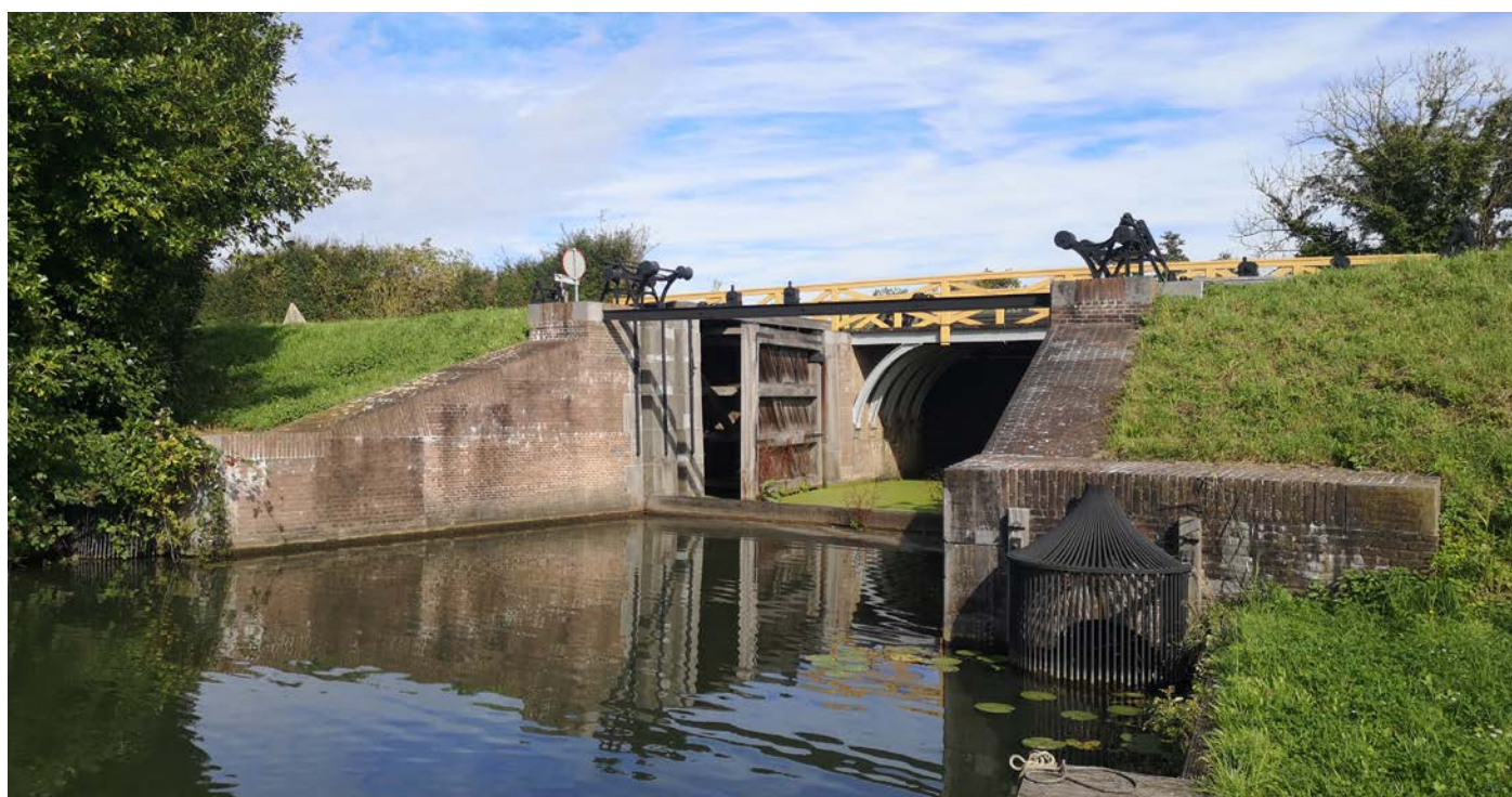
Foto van één van de waaiersluizen bij Asperen (2023)
