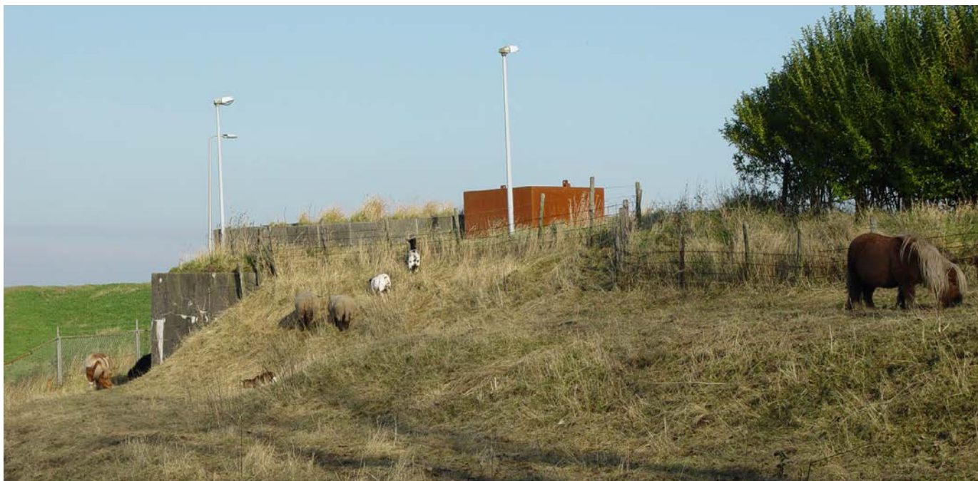
Foto van Batterij aan de Zuidelijke Lekdijk bij Hagestein (bron: kenniscentrumwaterlinies.nl)
