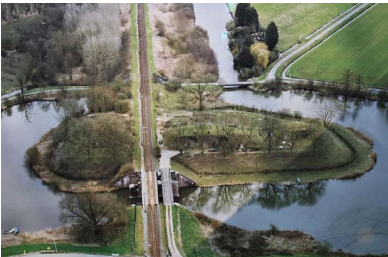
Foto van het Werk op de spoorweg bij de Diefdijk (Bron: Hollandsewaterlinies.nl)
