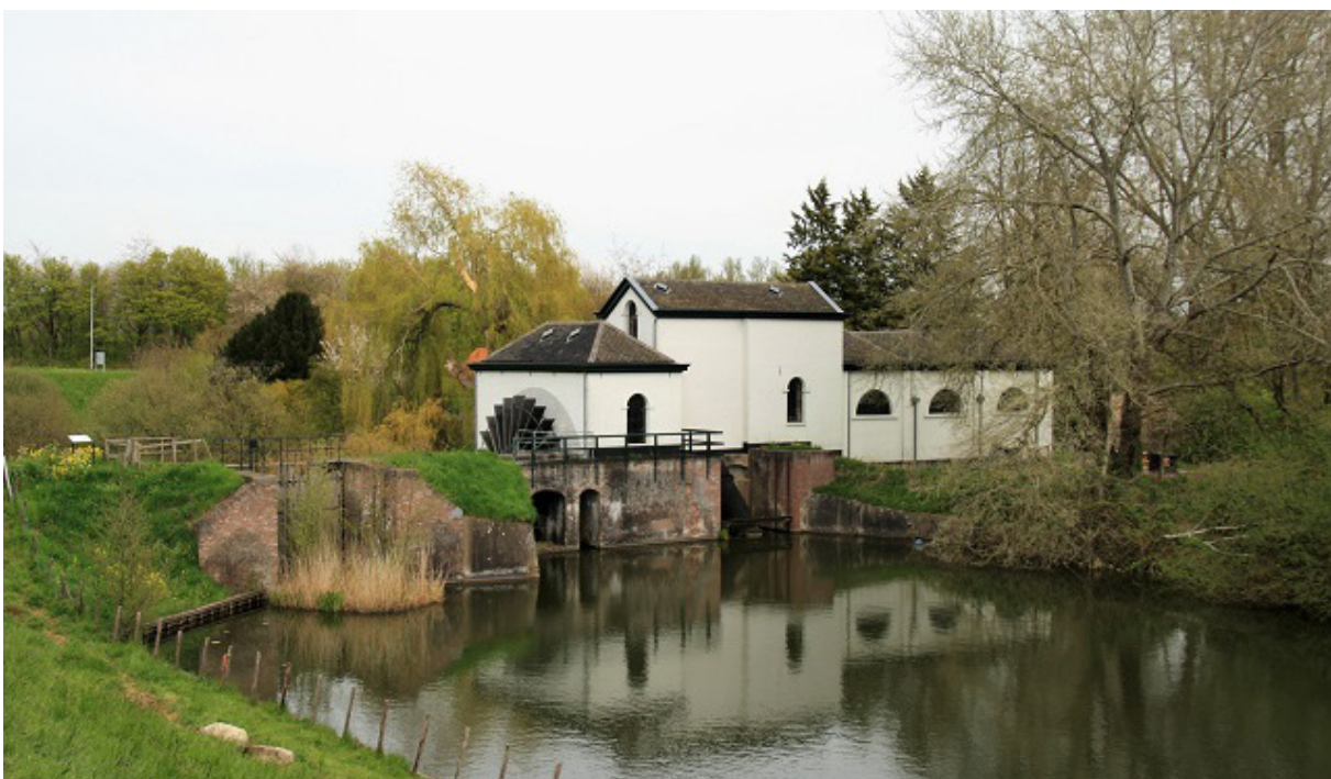
Afbeelding van sluis en gemaal Oude Horn (Bron: acquoy-westbetuwe.nl)
