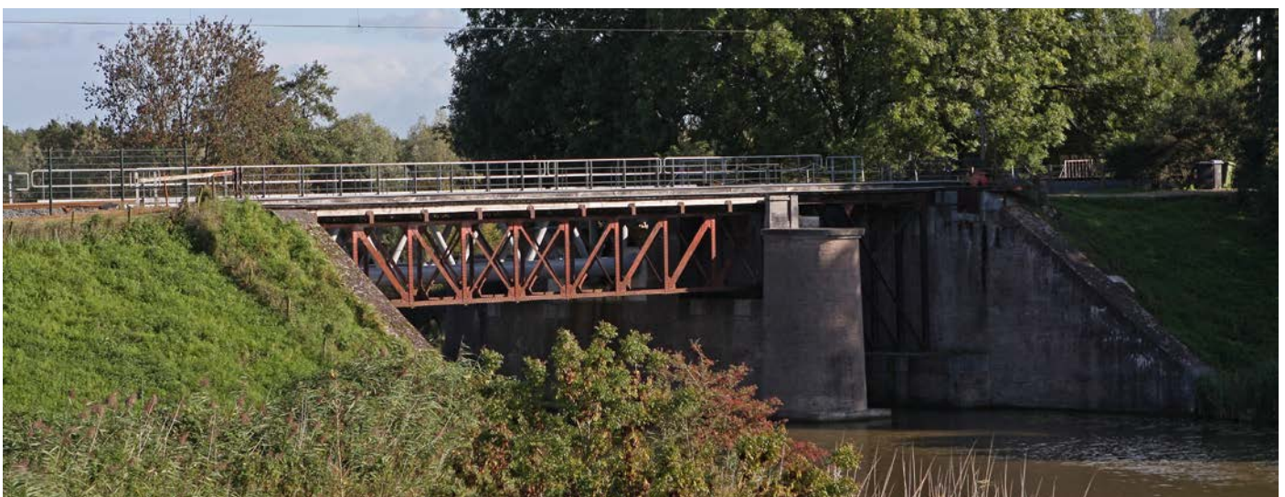
Foto van de kraanbrug bij Werk op de spoorweg bij de Diefdijk (Bron: Rijksmonumenten.nl)
