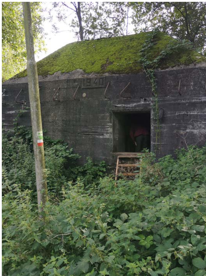
Foto van betonnen werk op het Fort bij Everdingen (2023)
