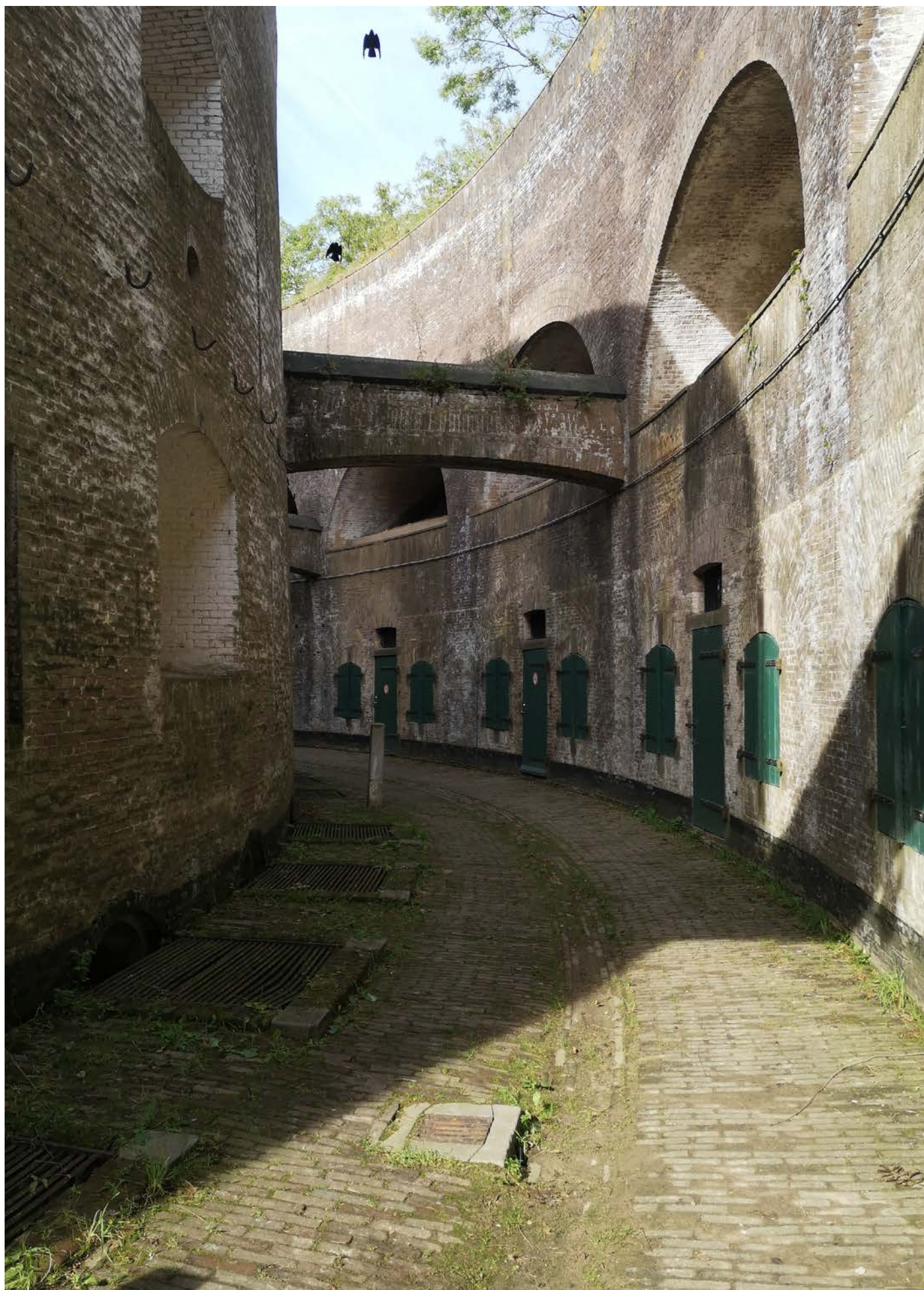
Foto van rondgang rond toren van Fort bij Everdingen (2023)
