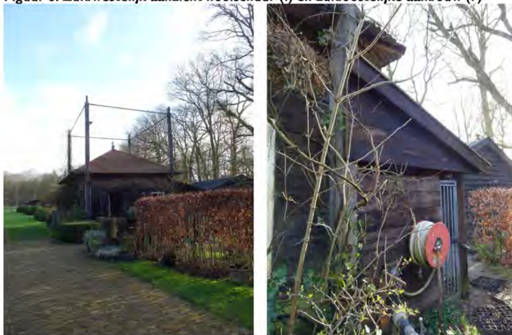
Figuur 6. Zuidwestelijk aanzicht hooischaar (l) en zuidoostelijke aanbouw (r)
