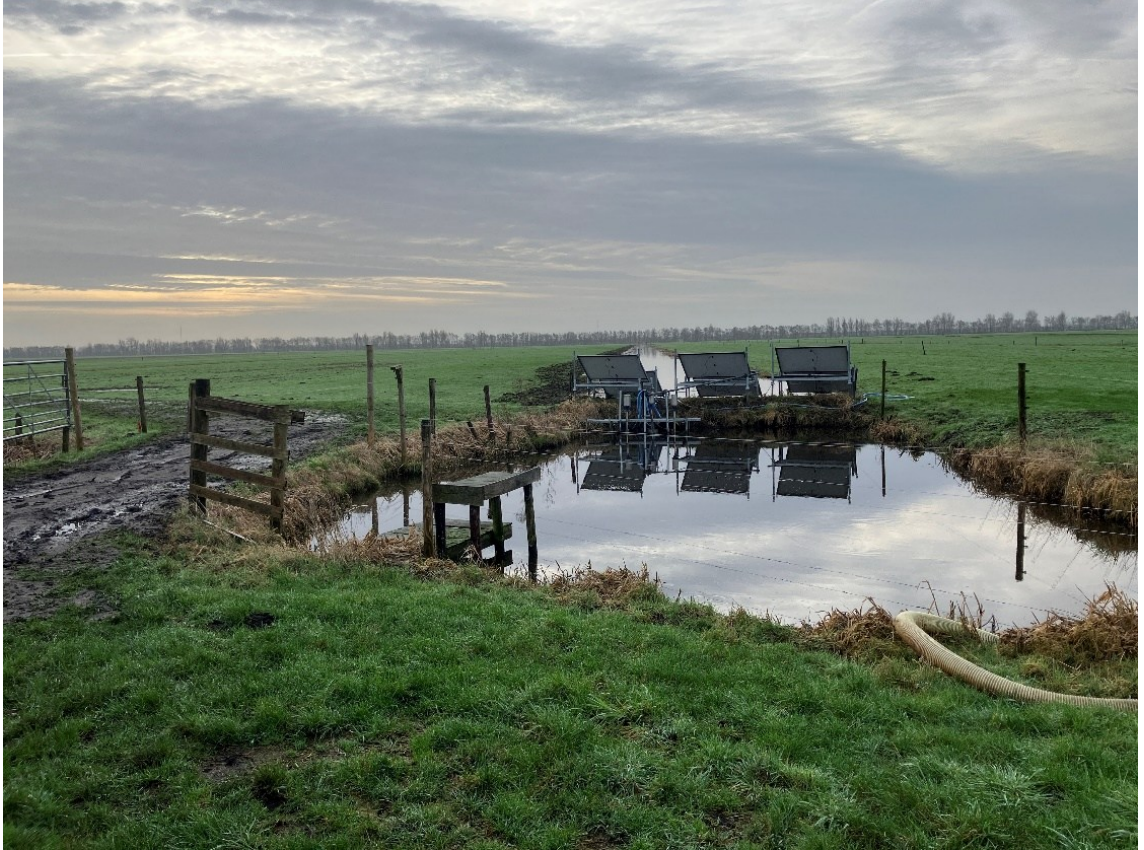
Een plasdraspomp is een van de belangrijkste hulpmiddelen bij agrarisch weidevogelbeheer. Met deze pomp worden stukken weiland onder water gezet om een gunstig foerageergebied voor weidevogels te creëren.
