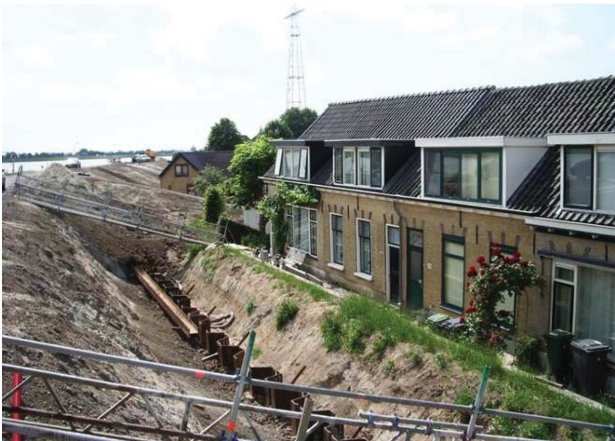
Foto: Dijkversterking aan de Lekdijk in de Krimpenerwaard. (Hoogheemraadschap Schieland en Krimpenerwaard)
