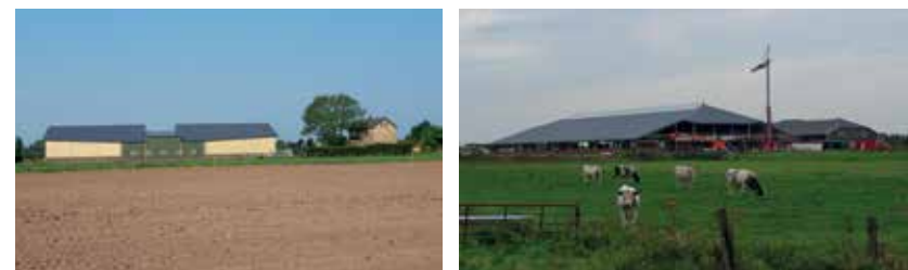
Twee voorbeelden van afwijkende dakvormen: een geknikt dak in combinatie met een verspringende plattegrond (Vallei, links) en twee stallen met wolfseinden in Eemland.
