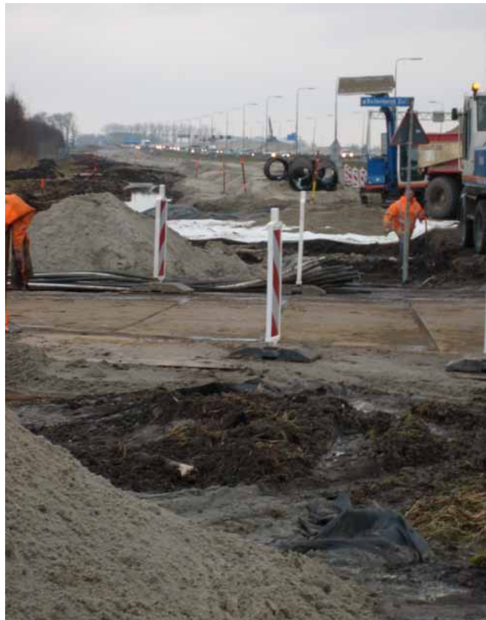
Figuur 3.1: Kabels en leidingen in de bodem.
