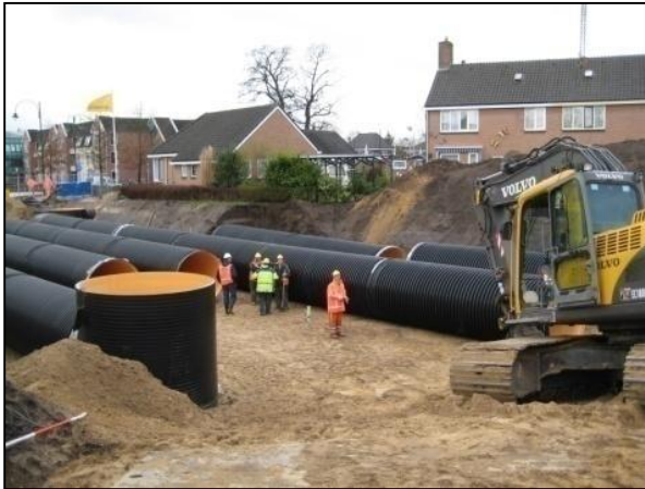
Figuur 11: IT-riool in aanleg met een uitzonderlijk grote diameter in Leersum
