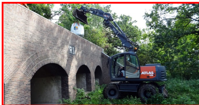
Werkzaamheden Fort bij Rijnauwen. (fotograaf: Fred Mijnten)
