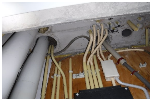
Afbeeldingen 1 en 2: voorbeelden van doorvoeringen die niet brandwerend zijn uitgevoerd.
