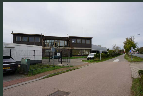
Voormalig autobedrijf Hessing
