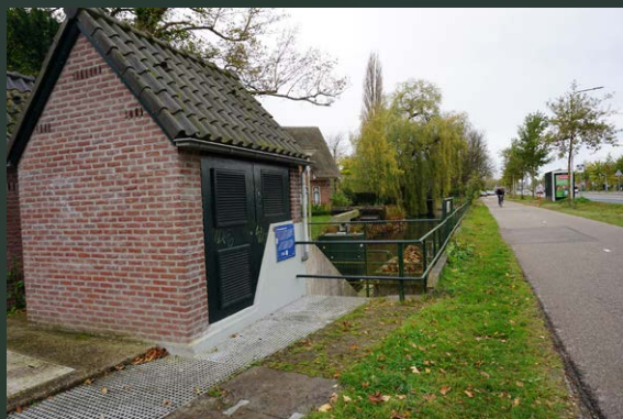
Stuw bij Sluishoef
