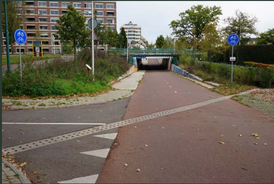
Het tunneltje onder de Utrechtseweg richting Dorpsstraat
