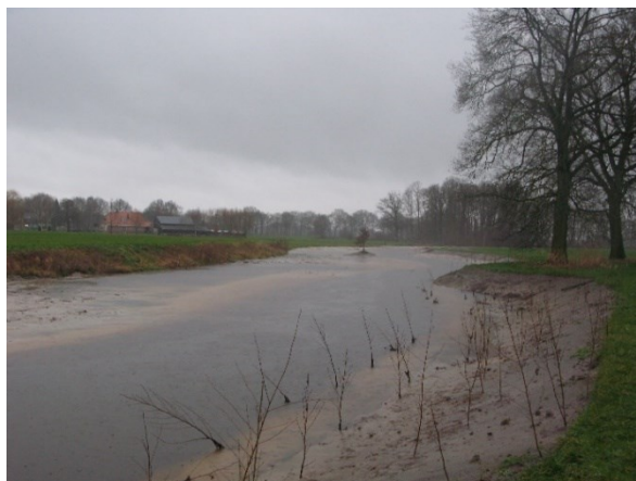
Afbeelding 9 Aanleg natuuroevers Luntersebeek
