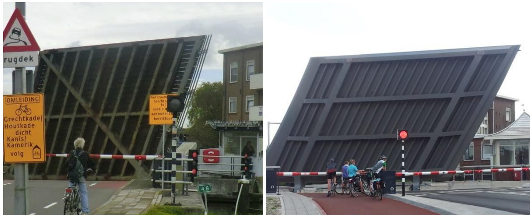
figuur 3 Oude en nieuwe brug: lichte constructie met een slijtlaag op een houten rijdek versus een zware constructie met daarop een asfalt overlaging.
